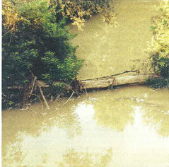
I tronchi nel torrente rischiano di provocare un pericoloso effetto diga
